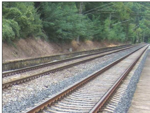
Bod 1, pohled na trať v místě měření
