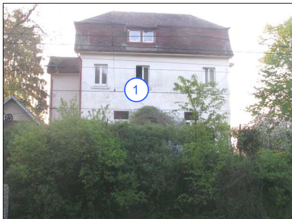
Bod 1, Sadová 52, fasáda k trati
