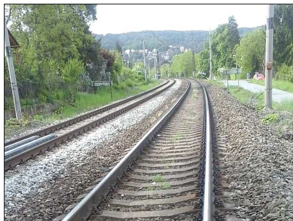
Bod 2, pohled na trať v místě měření
