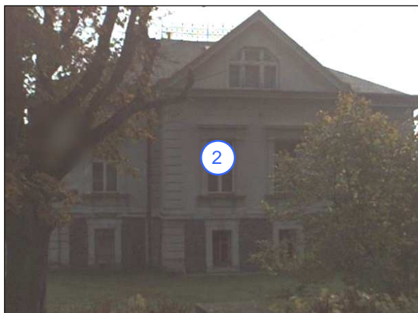
Bod 2, Zděnka Lhoty 464, fasáda k trati
